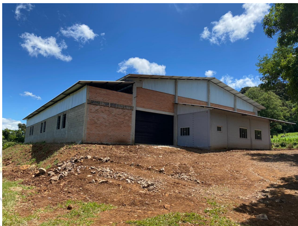
Imagem 02: fachada frontal e lateral
