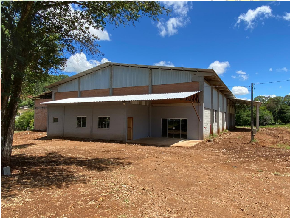
Imagem 01: fachada frontal e lateral
